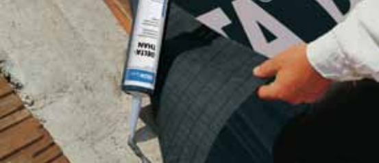
Надёжное примыкание к стенам с помощью клея DELTA®-THAN
