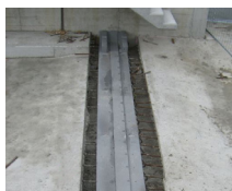
Швов перед бетонированием
