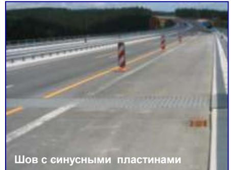
Шов с синусными пластинами
