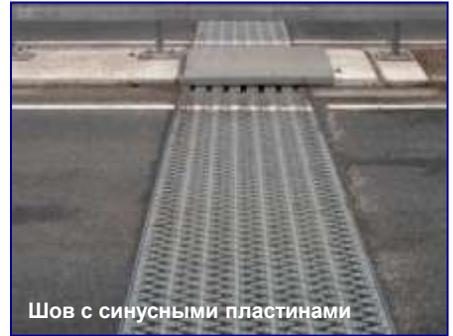
Шов с синусными пластинами
