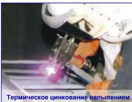
Термическое цинкование напылением
