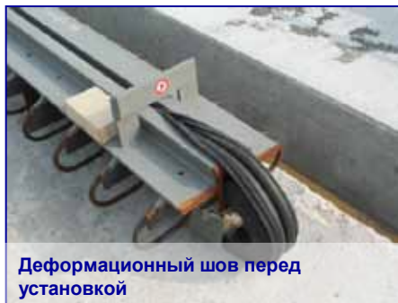
Пролётное строение перед монтажом деформационного шва
