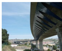
Viaduct Trapaganan (ES)
