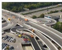
Bridge Glattzentrum (CH)
