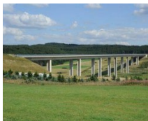
Liesertal Bridge (DE)
