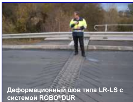
Деформационный шов типа RE-LS с системой ROBO®DUR
