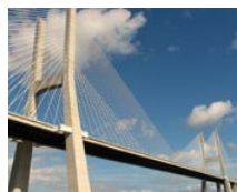
Мост Vasco da Gama (PT)
