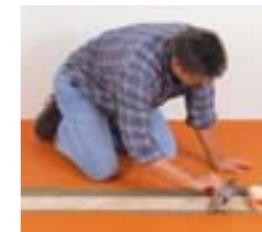
5. Для уплотнения стыков между полом и стеной также используется лента Schlüter®-KERDI. Для этого изоляционная лента в области пола плотно приклеивается к мату (мин. ширина 5 см), а в области стены непосредственно к основанию.
