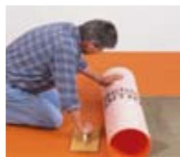
4. В целях создания гидроизоляции для покрытий, подверженных большой водяной нагрузке (санитарные помещения), на стыки матов Schlüter®-DITRA наклеивается изоляционная лента Schlüter®-KERDI шириной 12,5 см. Для этого на места стыков наносится клей для плитки на основе гидравлически вяжущего вещества, в который затем вдавливается изоляционная лента Schlüter®-KERDI.
